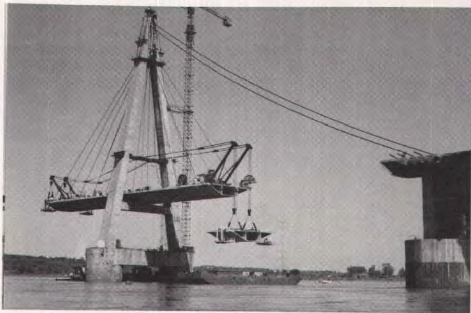
Fig. 43. Erection of Posadas Encarnación Bridge, Argentina.
